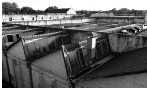
✓ Vue des toits depuis l'atelier du coton, 2019
