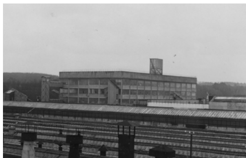
Vue du bâtiment de coton et blanchiment, 1950 Photographie appartenant à l'association du Patrimoine thaonnais
